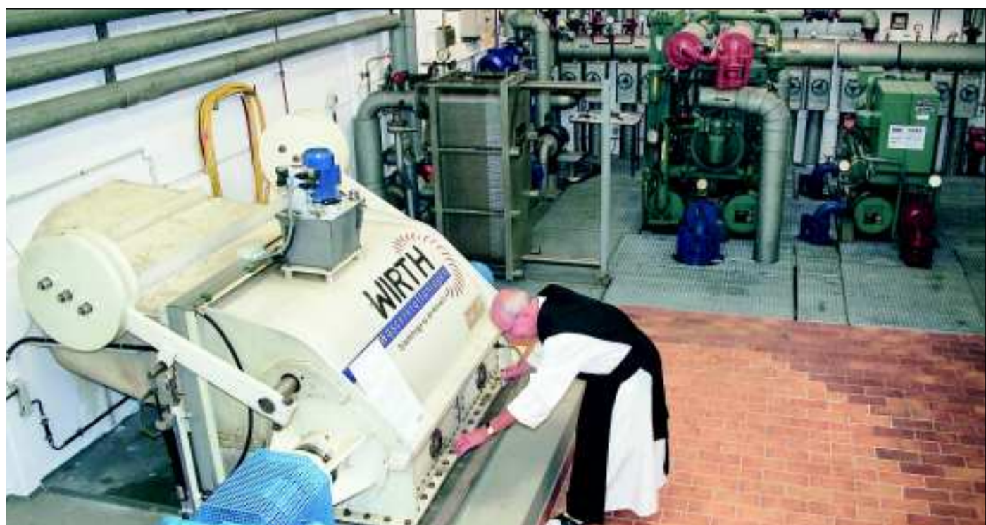
Gewissenhaft prüft der Zisterzienser Luftauslässe an der Turbine. Wasserkraft erzeugt in der Abtei Marienstatt Strom. Durch Wärmetauscher (Hintergrund) und weitere alternative Anlagen werden 1700 Tonnen CO-Ausstoß im Jahr vermieden. ■ Fotos: Dennis Jäger
