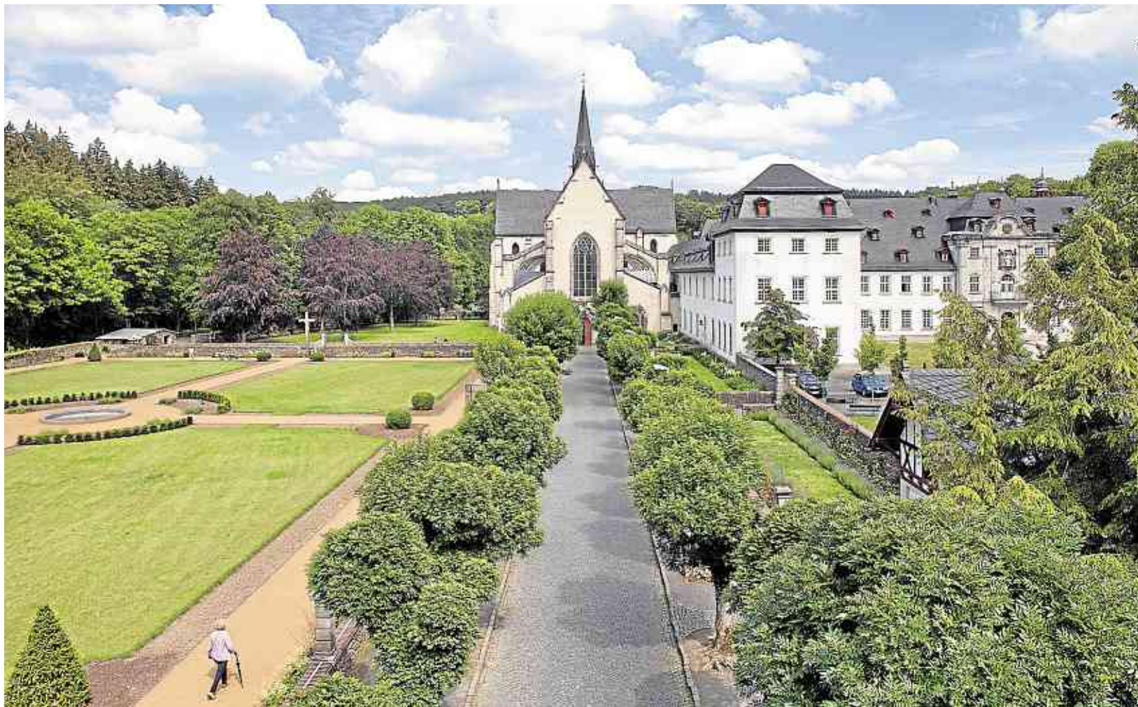
Nach der Generalsanierung zwischen 2000 und 2007 erstrahlt die Marienstatter Basilika in neuem Glanz. 2010 bis 2011 wurde auch der Barockgarten (links) neu gestaltet. Dieses Vorhaben wurde unter anderem vom Forum Abtei Marienstatt gefördert.
